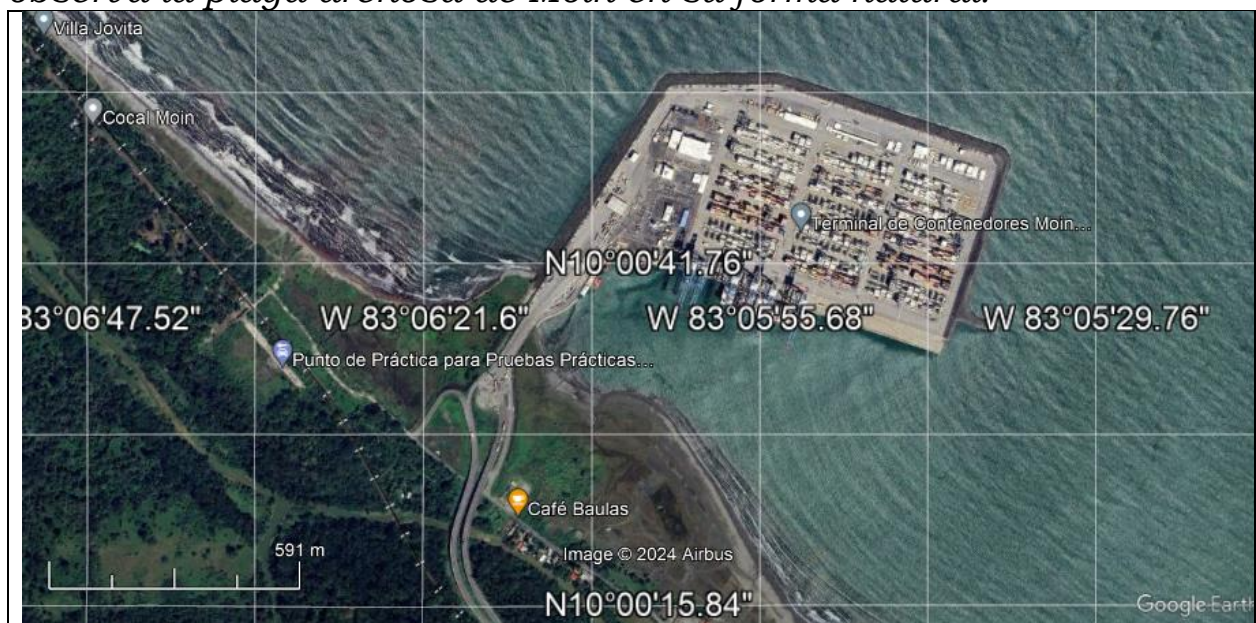
Foto. 2. Imagen de Google Earth del mes de febrero del 2024. Se observa la playa arenosa de Moín totalmente impactada por la acumulación de sedimentos como producto de la construcción de la isla artificial, sin que se realizaran los dragados de sedimento que la empresa se comprometió a realizar en el EsIA.
